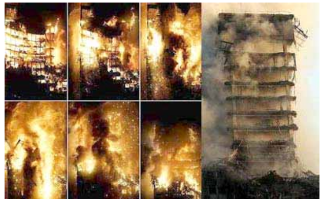
写真1 ウィンザービルの南側ファサードの崩壊の過程
